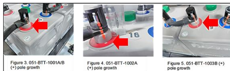
Gambar 5. Pengukuran pertumbuhan kutub baterai VRLA
