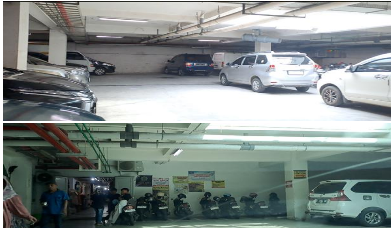
Gambar 6. Basement Mendapatkan Pencahayaan Alami Melalui Skylight Pyramid yang Terhubung Langsung dengan Aloon-Aloon Masjid Agung
