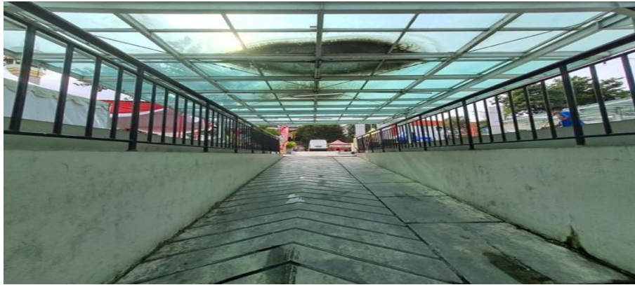
Gambar 3. Node Utama Berupa Kanopi Kaca yang digunakan Pada Masing-Masing Entrance dan Exit Parkir Basement
