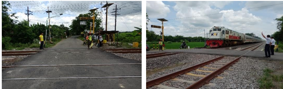
Gambar 5 Kondisi PJJ No 13
