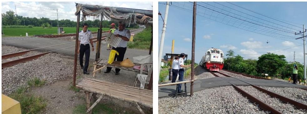
Gambar 3 Kondisi PJI No 3
