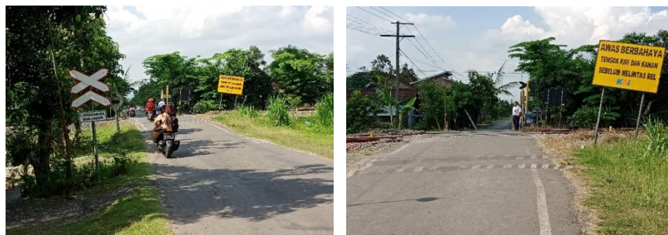
Gambar 2 Kondisi PJL No 113
